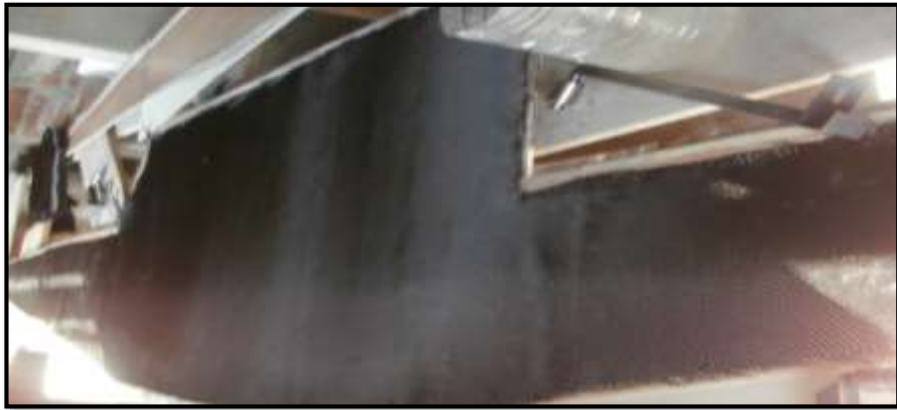
Figura 79-3: Recubrimiento total de fibra y de resina
