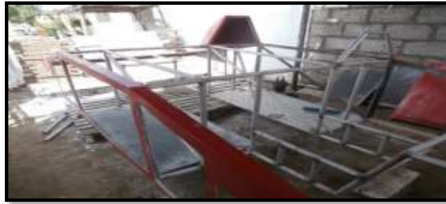
Figura 66-3: Remoción total del exceso de fibra de vidrio
