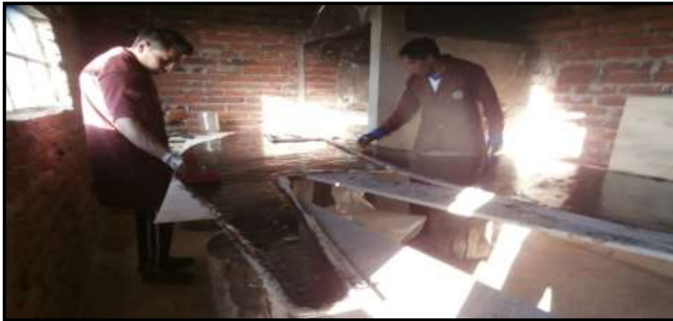
Figura 78-3: Colocación de la primera capa de fibra
