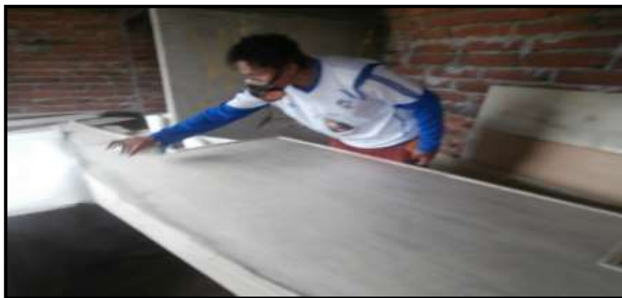
Figura 76-3: Aplicación del desmoldante
