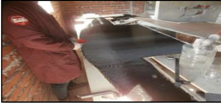
Figura 77-3: Aplicación de la resina sobre el tejido
