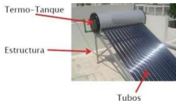
**Figura 2- 6:** Componentes de un calentador solar
