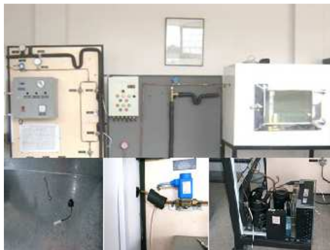
Figura 4.8: Instalación de los sensores de temperatura
