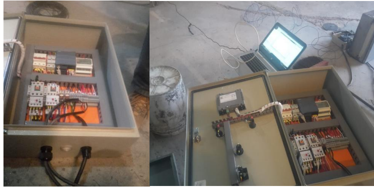
Figura 13-4. Transferencia del programa al PLC y HMI Realizado por: Henry, Acaro; Marco Terán, 2019
