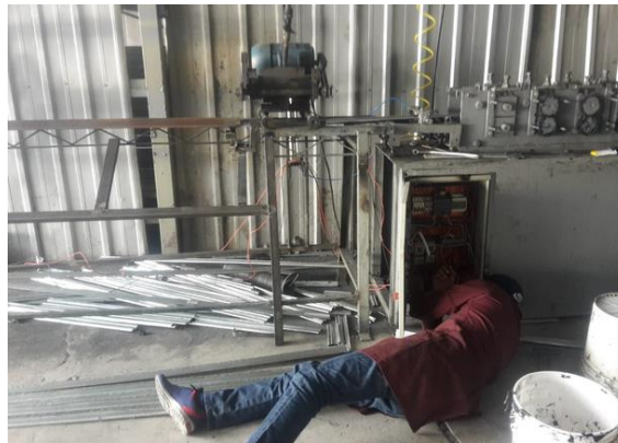
Figura 14-4. Instalación de la caja de control Realizado por: Henry, Acaro; Marco, Terán, 2019
