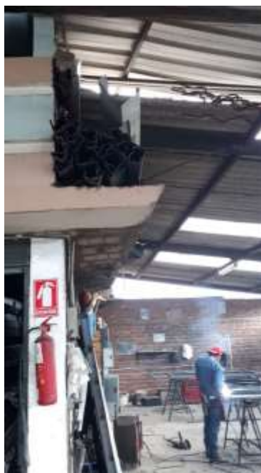
Figura 3-3: Tubos de acero galvanizado.
