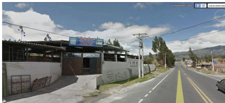
Figura 1-4: Localización, Industrias Metálicas Vilema
