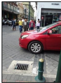
Figura 4-1: Estado Actual Calle
