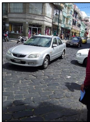
Figura 3-1: Estado Actual Calle
