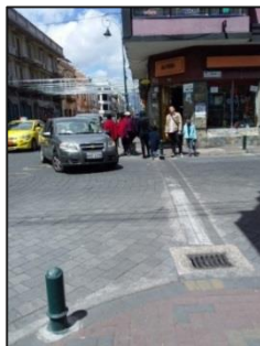
Figura 5-1: Estado Actual Calle
