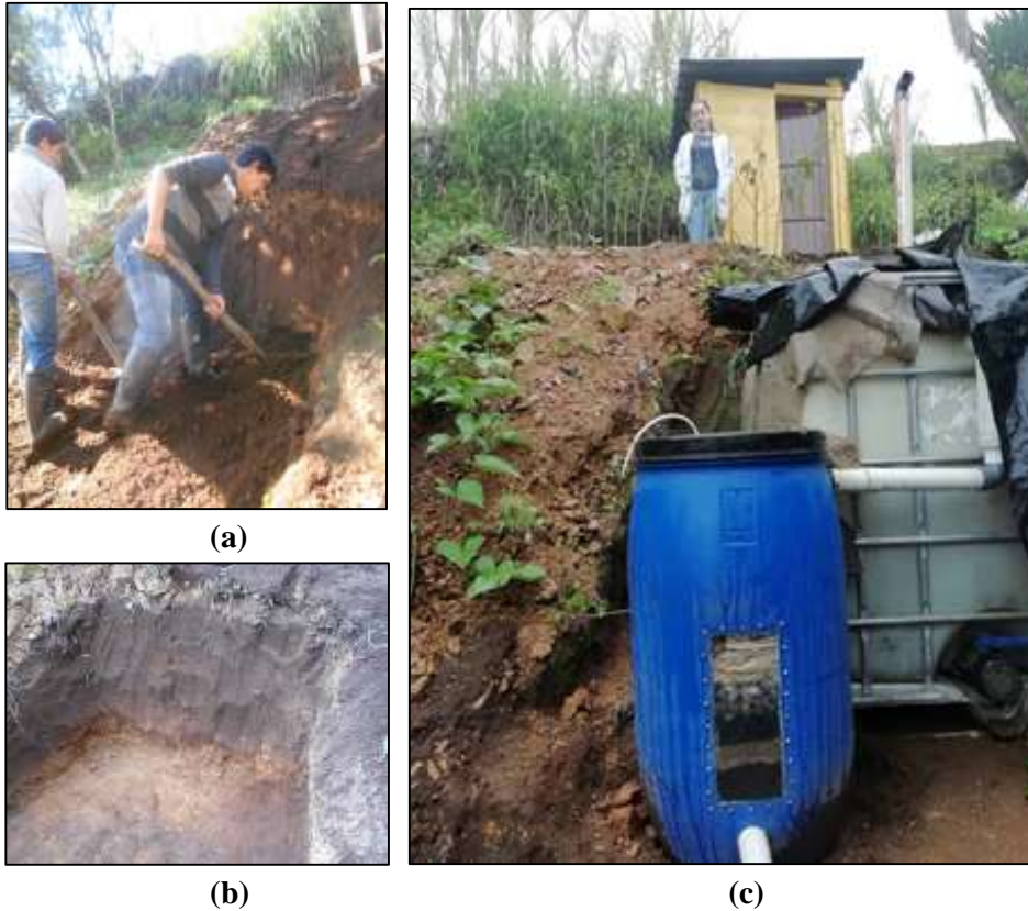
Figura 15-3: Instalación de la fosa séptica Fuente: Vanessa Fernández. (Ver Anexo J y K)
