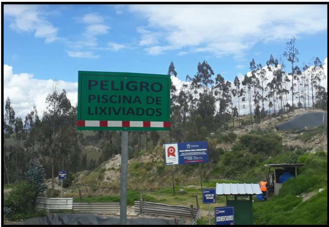
Fotografía 1-2: Tanque colector de lixiviados. Realizado por: Naranjo, María; 2019.
