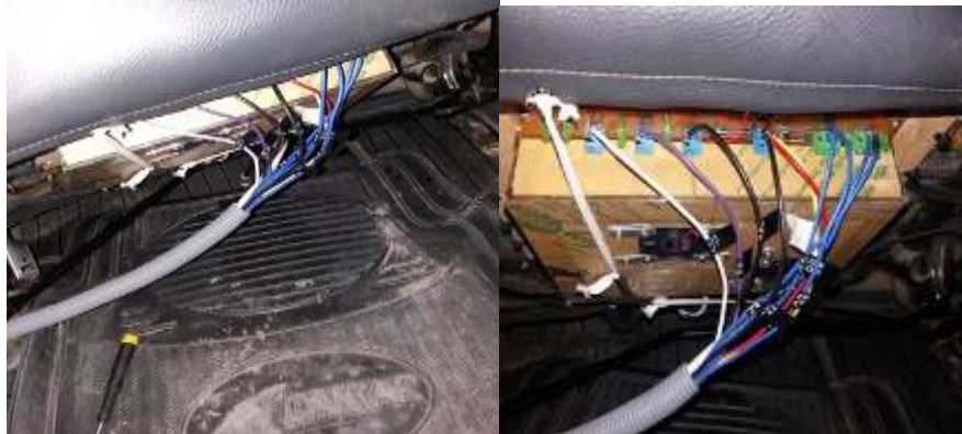
Figura 86-2: Instalación del prototipo y conexión de cables en el vehículo Realizado por: Tapuy, W. 2018
