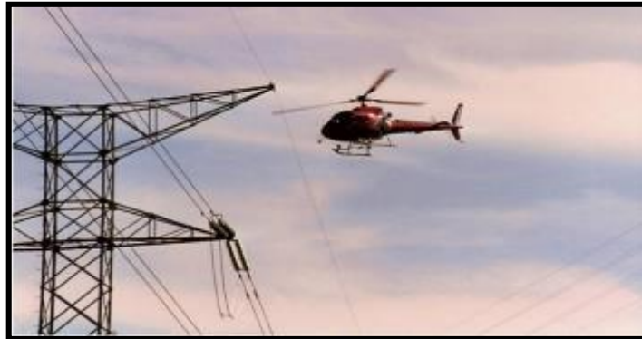
Figura 1-1. Inspección de redes eléctricas mediante un helicóptero.
