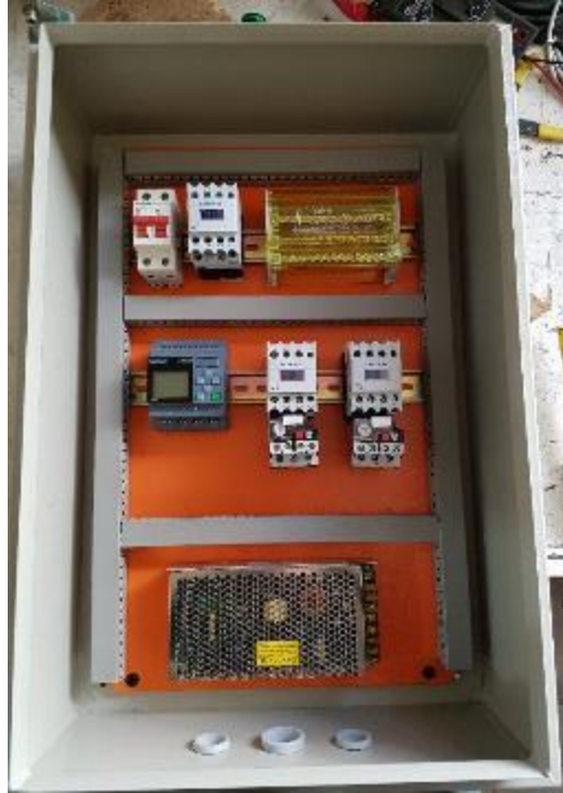
Figura 13-2 Colocación de componentes. Realizado por: Gavilanes A. 2018
