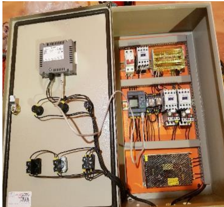
Figura 15-2 Peinado de conductor. Realizado por: Gavilanes A. 2018
