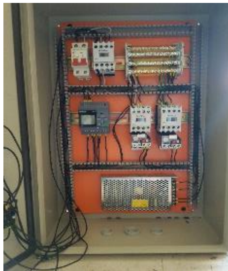
Figura 14-2 Colocación de componentes. Realizado por: Gavilanes A. 2018
