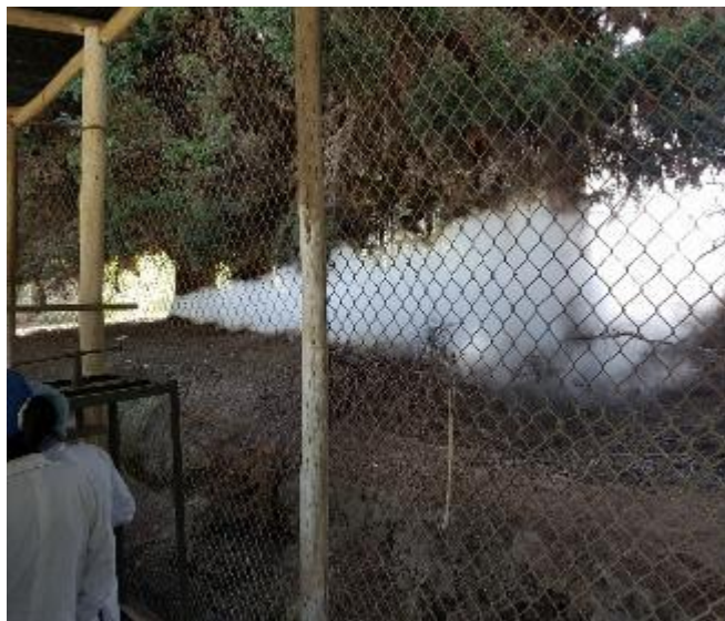
Figura 34-2 Salida de Vapor Realizado por: Gavilanes A. 2018
