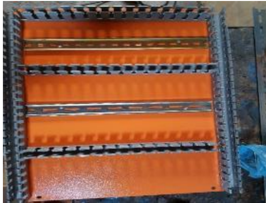
Figura 11-2 Colocación de riel y canaleta. Realizado por: Gavilanes A. 2018
