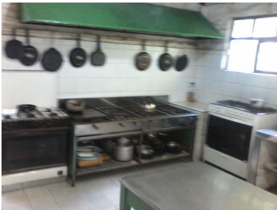
Área de Cocina Caliente
