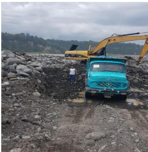
**Fotografía 22:** creación de pozos de extracción.
