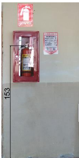
Figura 39-5. Instalación de extintor
