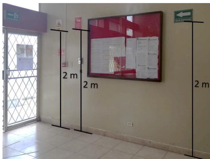
Figura 9-5: Señalética de Adv, ECU911 y Vía de evac. según NTE INEN 2239.
