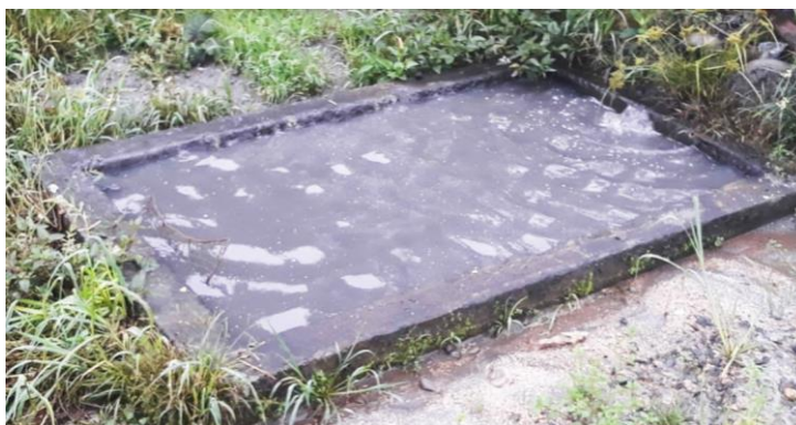
Fotografía 15-1: Almacenamiento de lixiviado crudo Realizado por: Emilys Mosquera, 2018.
