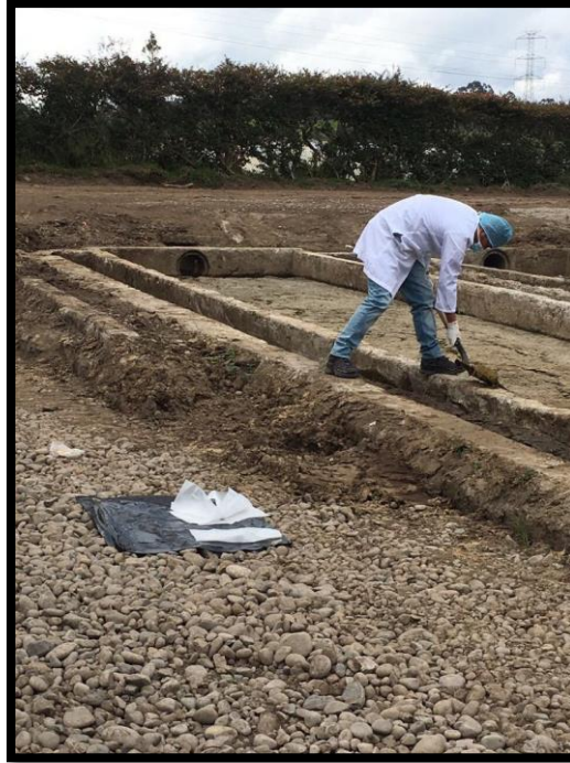
Figura 2-2: Extracción del lodo de las eras de secado.
