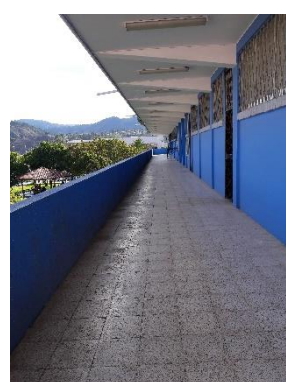
Figura 11-3. Corredor tercer piso
