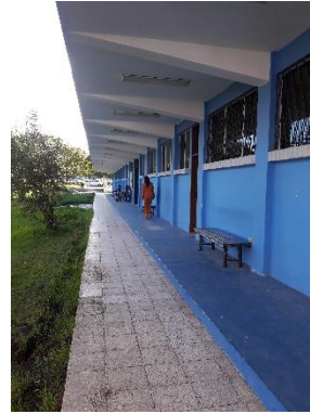
Figura 9-3. Corredor primer piso
