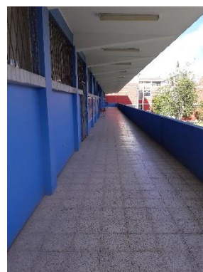
Figura 10-3. Corredor segundo piso
