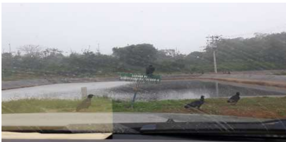
Ilustración 15 Laguna de lixiviado del botadero de basura de Santo Domingo.
