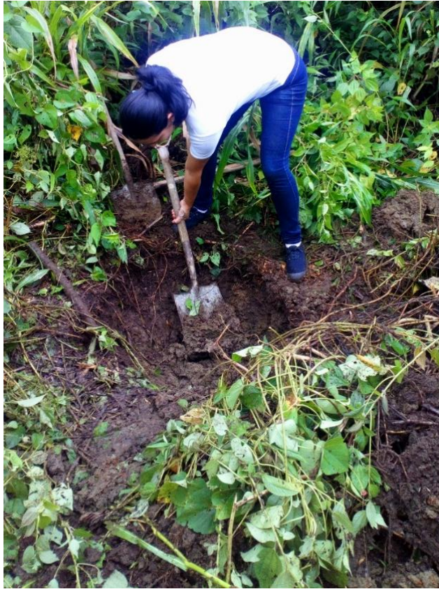
Anexo 14: Realización de calicatas
