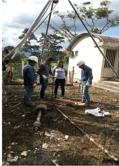
Anexo 9: Ensamble del equipo SPT
