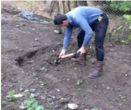
Fotografía 4-2. Limpieza y preparación del área seleccionada para la construcción.
