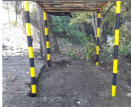
Fotografía 5-2. Construcción de la caseta para la producción de biogás.
