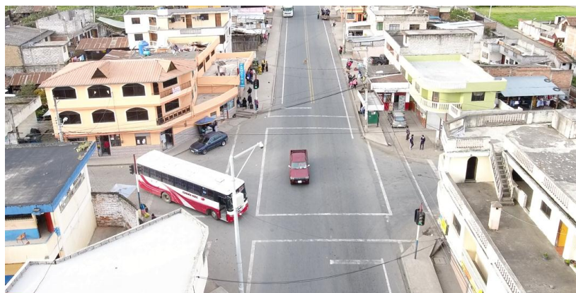
Gráfico 7: Intersección N°1 Av. Padre Leónidas Proaño y Calle Progreso
