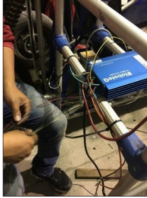
Figura 14-4: Montaje del controlador HBL 2360 al prototipo solar
