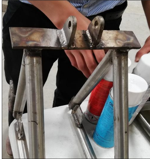
Figura 3-5: Limpieza de anclaje.
