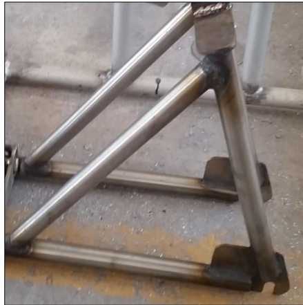
Figura 31-4: Soldadura de tubos marco posterior
