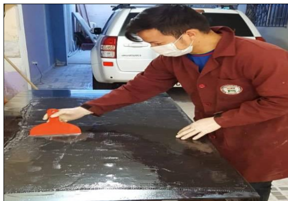
Figura 18-4: Saturación de la fibra de carbono.
