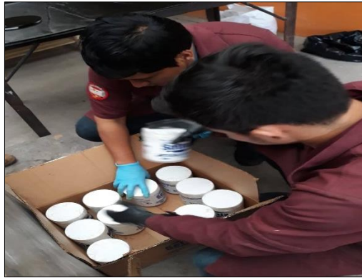
Figura 6-4: Resina epoxi para la saturación de la fibra de carbono.
